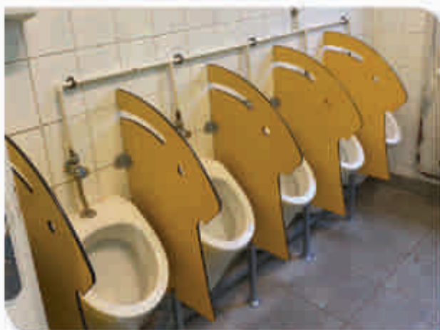
Installation de panneaux d'intimité entre les urinoirs des WC garçon à l'école primaire
