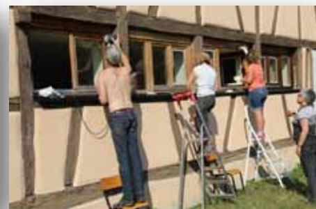
Traitement des boiseries de la salle paroissiale
