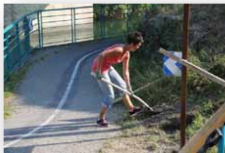
Installation des panneaux du sentier de la fouine. Gros travail entre pioche et béton.
