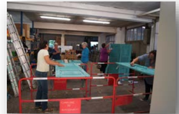
Ponçage et remise en peinture des volets de la mairie
