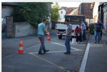
Remise en peinture de la signalisation routière
