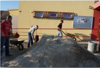
Mise à niveau du sol de la réserve de la salle Marcel Meyer
