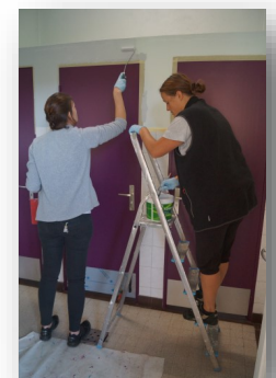
Rafraîchissement des toilettes de l'école primaire
