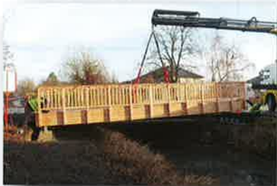
Mise en place d'une passerelle
